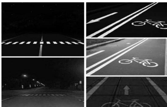
Рис. 1 - Пример нанесения фотолюминесцентных надписей на полотно дороги
