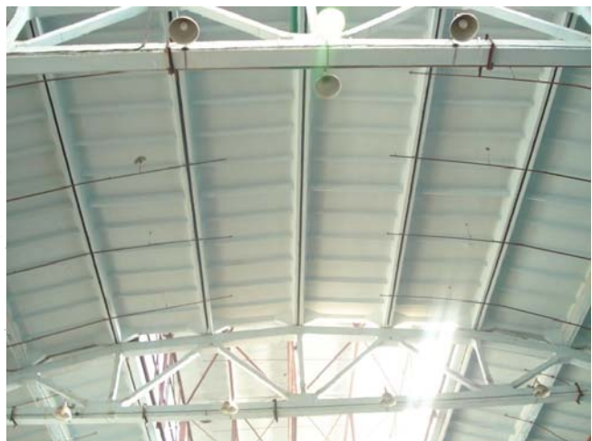
Рисунок 9 Железобетонные плиты покрытия
