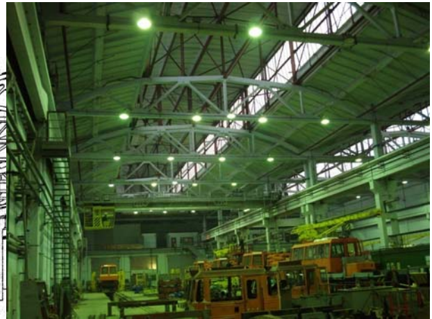
Рисунок 3 Каркас промышленного здания
