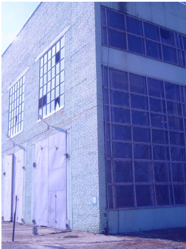
Рисунок 12 Боковой и главный фасады промышленного здания ОАО ТМЗ завод им В. В. Воровского сборочный цех
