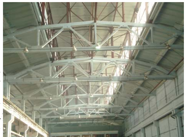
Рисунок 5 Железобетонные стропильные фермы
