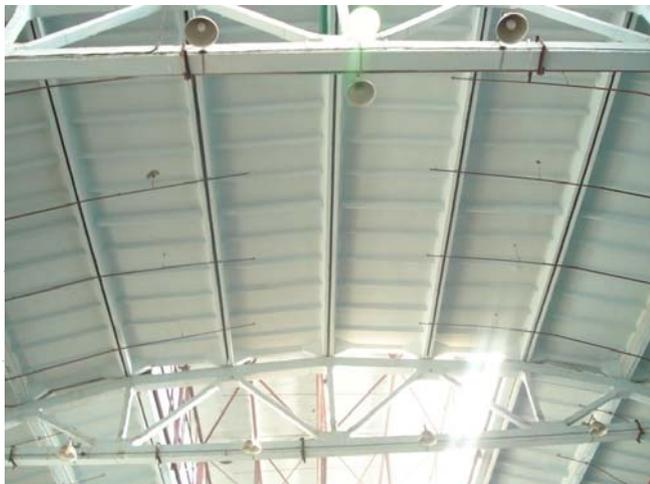
Рисунок 8 Железобетонные плиты покрытия
