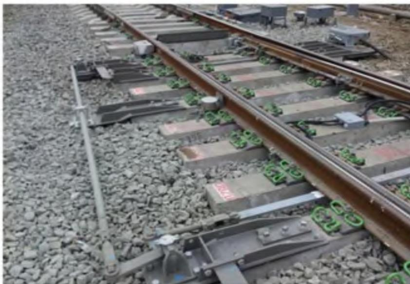
Рисунок 21 – Стрелочный перевод со скреплением Vossloh
