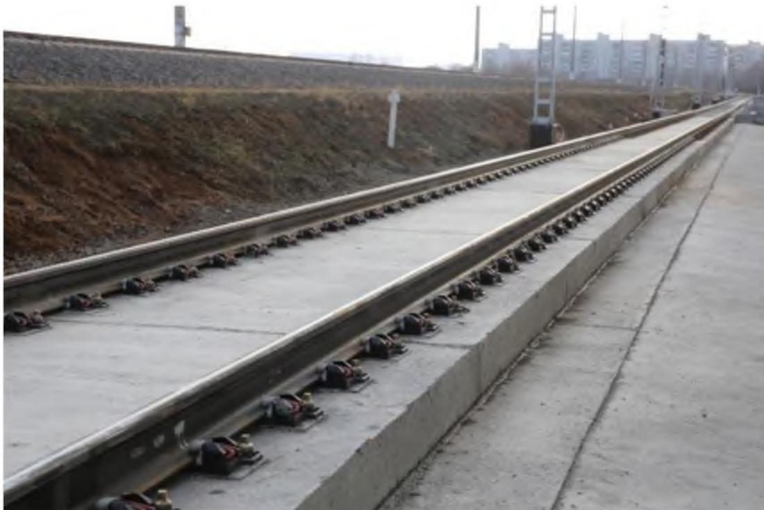
Рисунок 19 - Компания ALSTOM (Альстом) – конструкция NBT
