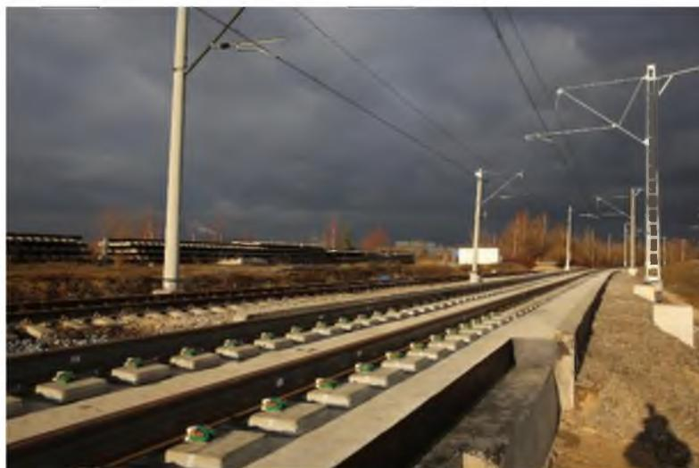
Рисунок 16 - Безбалластное полотно Компании ОАО «РЖДстрой» – конструкция LVT
