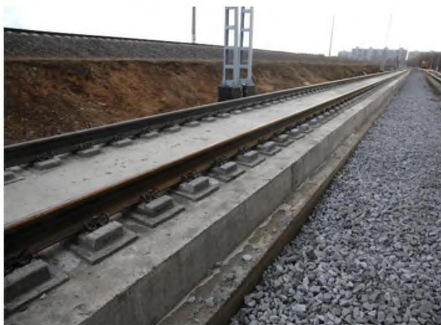
Рисунок 20 - Компания TINES (Тинес)– конструкция EBS
