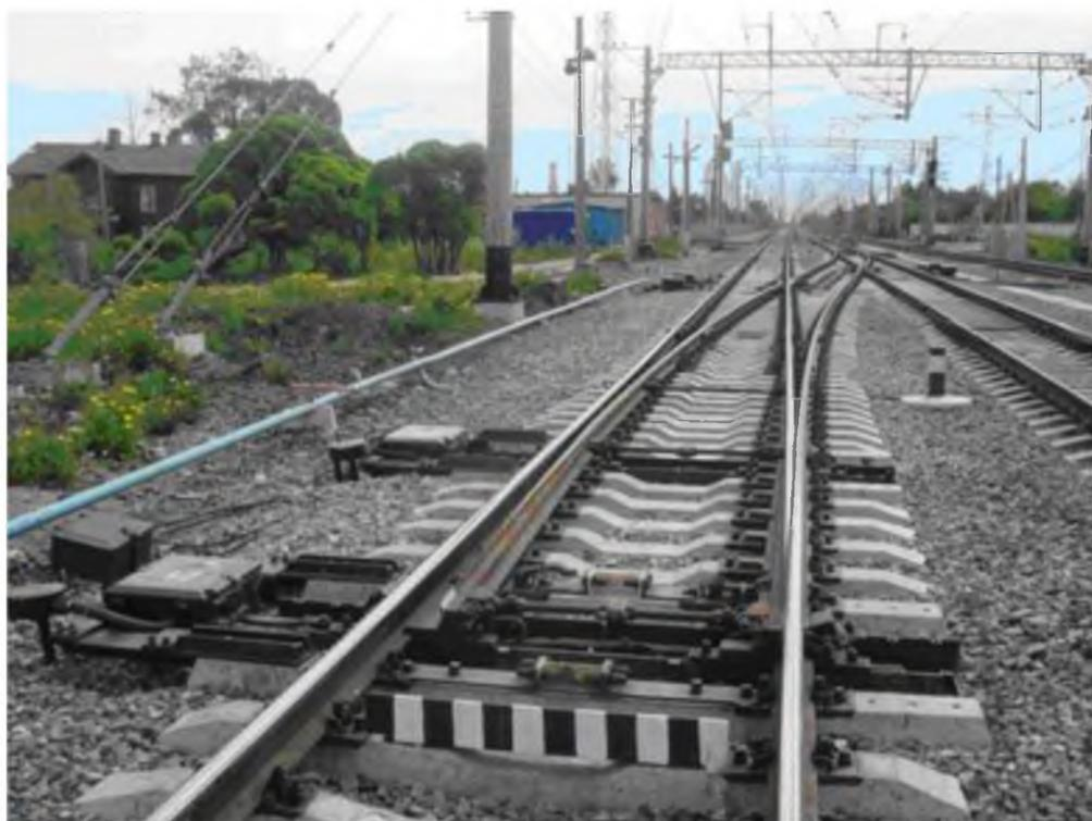
Рисунок 23 - Стрелочные переводы и съезды проектов 2956 и 2968 для скоростей движения до 250 км/ч.
